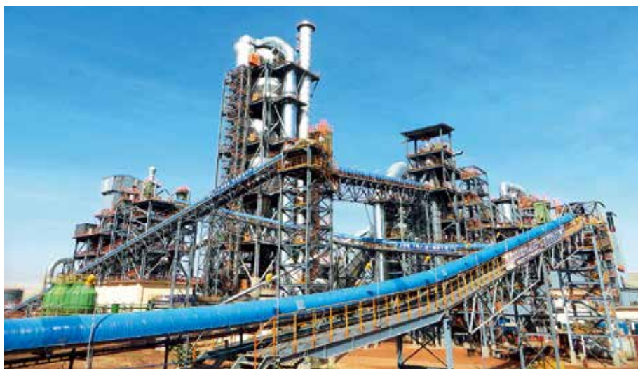
中材建设尼日利亚有限公司工厂
