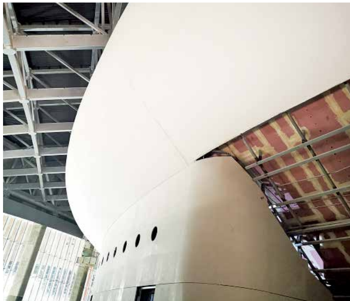
亚运会场馆无木吊顶系统照片
